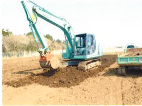
スケルトン(格子目)バケットによる大径石礫の除去
