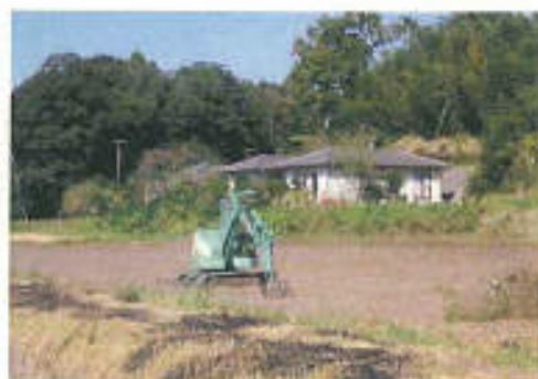
バックホーによる整地作業
