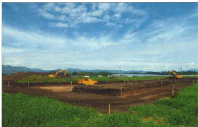
【再生整備開始!!】優良農地へ（西都市下三財）H25.9.6 ※石礫を畑の下層に入れ込み表土50cm以上を確保します。
