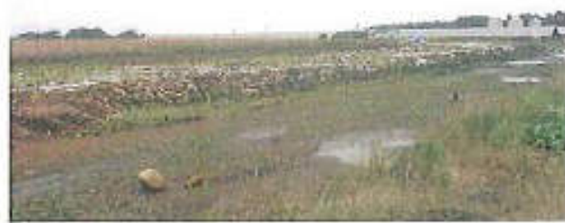
埋却地の状況（石礫が多数露出している）
