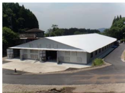
④施設全景
