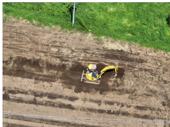
バックホウによる施工状況
